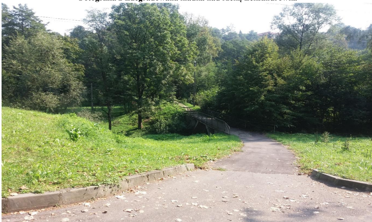
Fotografia 2 Zdegradowana kładka nad rzeką Leksandrówka
