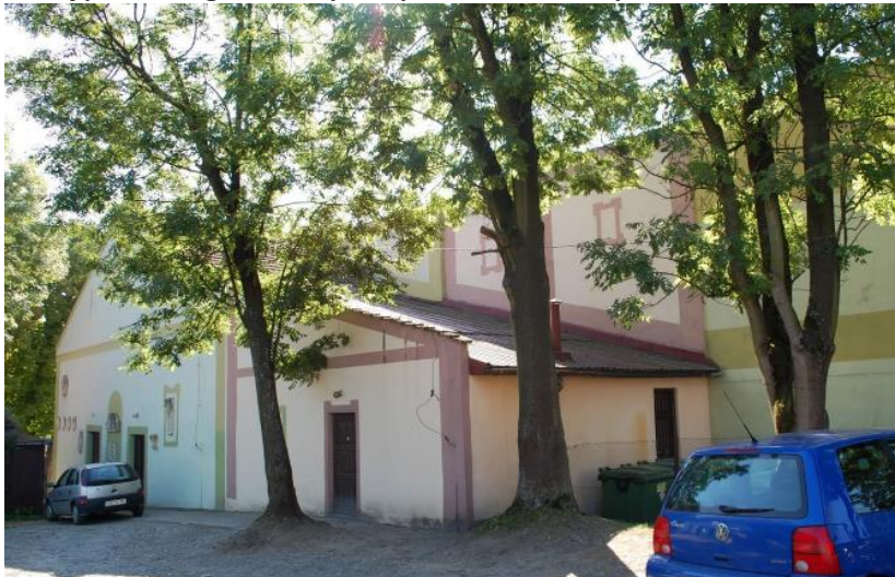
Zdjęcie 7 Zdegradowany budynek kina w Nowym Wiśniczu
