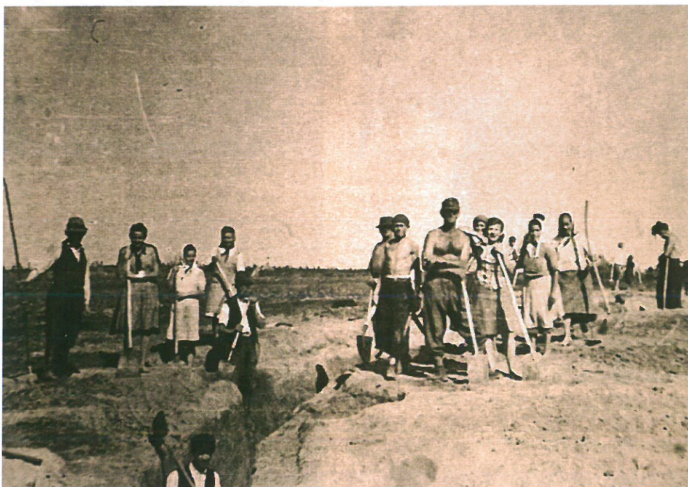
Prace przy kopaniu okopów w Kobylu z udziałem ludności więzionej w niemieckim obozie pracy. Fot. z prywatnych zbiorów
