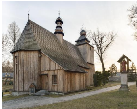
Kościół pw. Nawiedzenia Najświętszej Marii Panny w Paczółtowicach, 1515-1528, fot. M. Jeżyk
